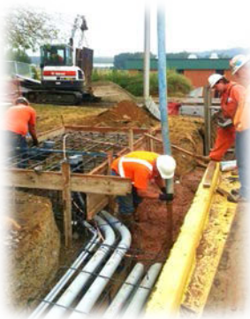
Pouring electrical ductbank
